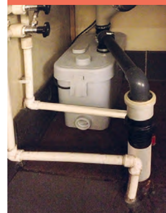
Čerpadlo SANISPEED® nainstalované pod kuchyňským dřezem
