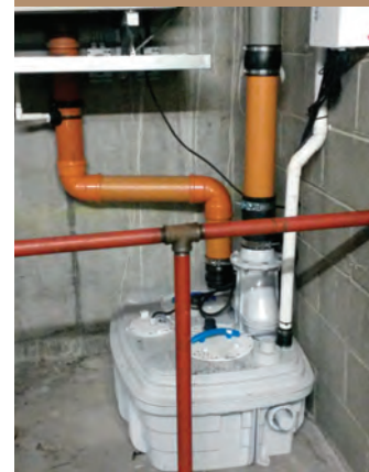
SANICUBIC® 2 XL instalovaný v technické místnosti
