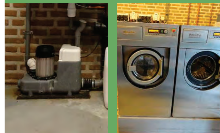
Čerpadlo SANICOM® 1 instalované v suterénu
