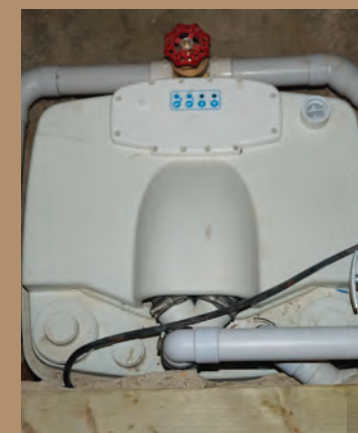
SANICUBIC® 2 Classic instalovaný v suterénu
